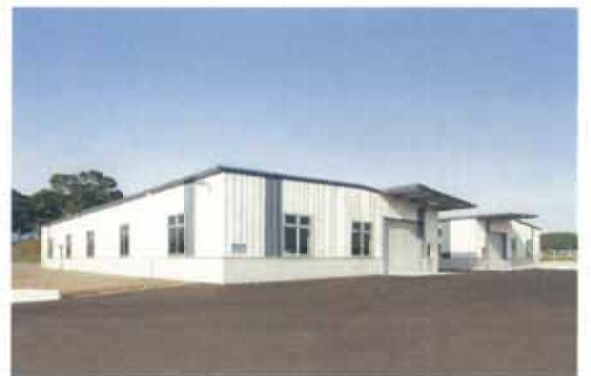
フォーム化工(株)宮若工場新築工事
