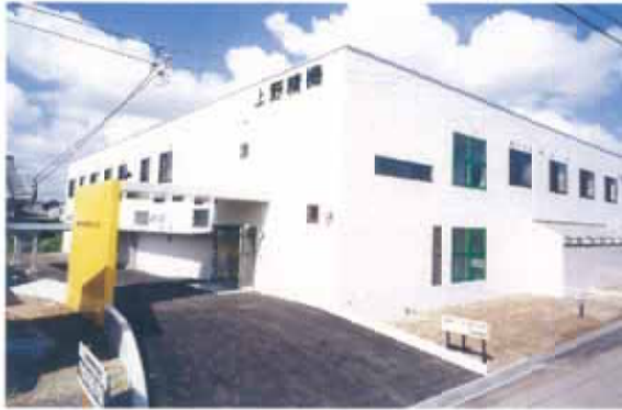
上野精機(株)工場増築工事
