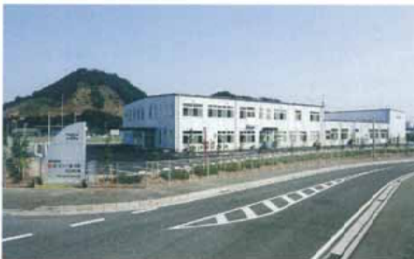
(株)カンノ製作所北九州工場新築工事
