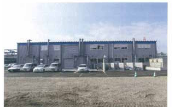
(株)新菱R&Dセンター新築工事
