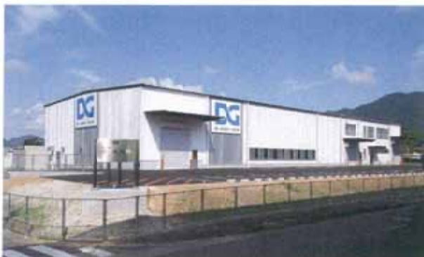
(株)第一製作所九州工場新築工事
